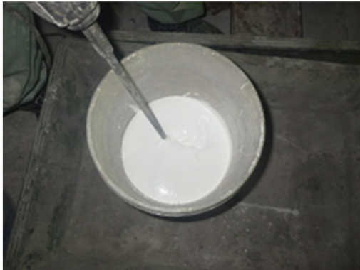
TSボンド ® 40Sと骨材を混ぜ攪拌
