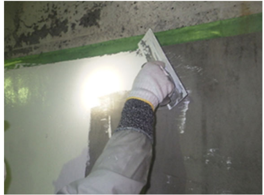
TSボンドモルタルを塗布
