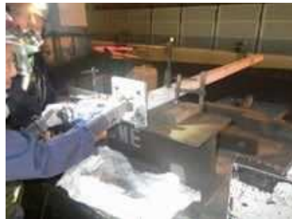
試験施工状況 拡孔状況
