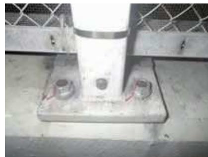
試験施工 設置後
