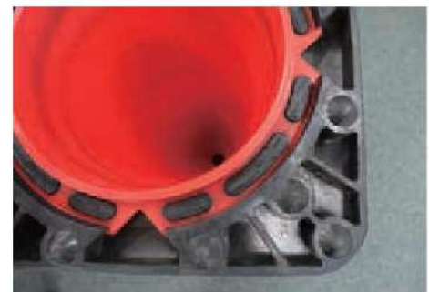
コーンとベースの嵌め込み構造 (コーンの長孔とベースの突起を嵌合)
