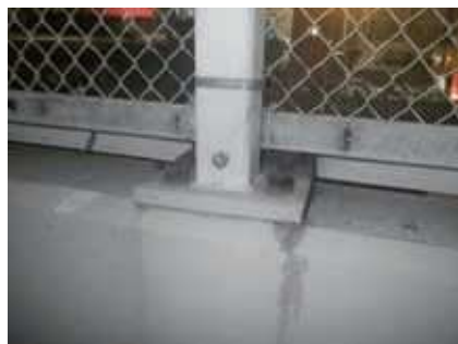
試験施工 設置前
