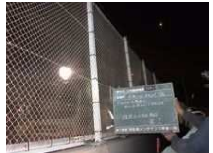
試験施工箇所 全景
