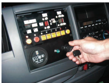
発電機スイッチON
